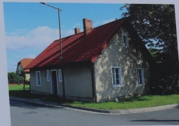
Budynek Franciszka Krajewskiego, frontowca kawalerzysty.
