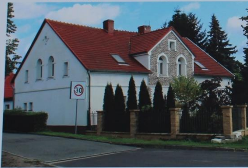
Najstarszy budynek w Tyńcu M., znajdujący się w wykazie zabytków. Mieszka tu rodzina Karola Sobczaka, byłego Przewodniczącego GRN w Tyńcu Małym.
